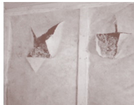
断熱材施工風景
