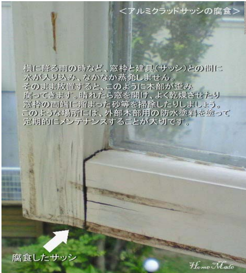
＜腐食の進んだ木製サッシ(アルミクラッド)＞
